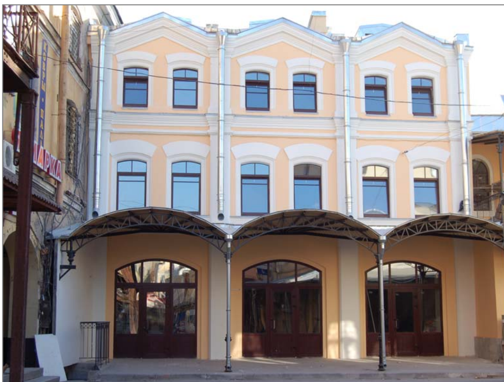
Del av utvecklingsfastigheten på adressen Apraksin Dvor 15/16, där Ruric genomfört omfattande ombyggnation under första kvartalet 2007
